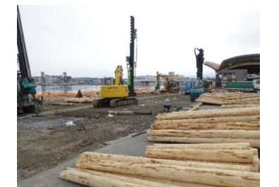
(開発工法の施工例 (青森県八戸港館鼻岸壁、丸太使用本数：約 8,600 本))
