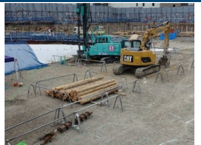
(開発工法の施工例 (高知市役所新庁舎、丸太使用本数：約 13,500 本))
