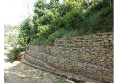
日ネ技術者の共同施工によりネパール国内に完成した「改良型防災蛇籠擁壁」
